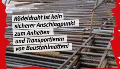
Röddeldraht ist kein sicherer Anschlagpunkt zum Anheben und Transportieren von Baustahlmatten!
