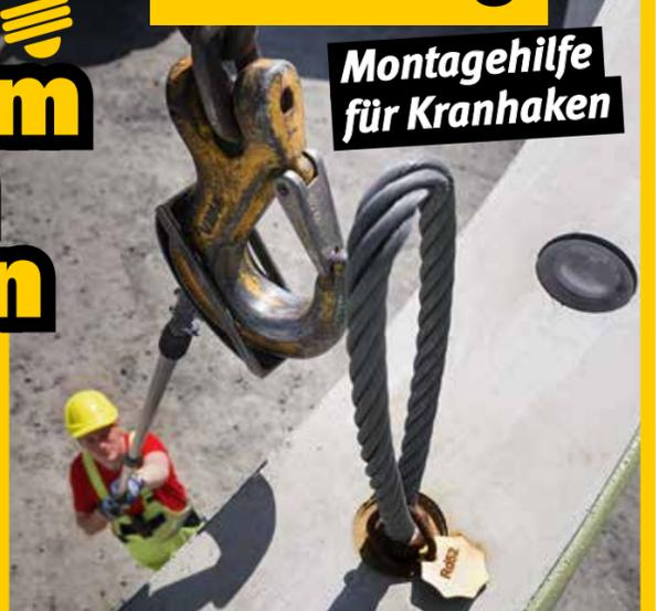
Schwere Betonfertigteile werden üblicherweise per Kran transportiert. Die Lasthaken müssen dafür per Hand an den Teilen ein- und ausgehängt werden. Bei großen Betonfertigteilen wird oft von Leitern aus gearbeitet. Hier kann es zu Abstürzen oder Handverletzungen kommen.
