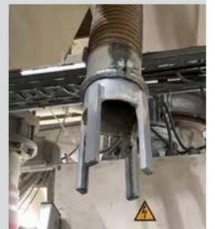
Über diese Stutzen im hinteren Bereich der Anlage wurde unnötig Luft gezogen. Um zu sehen, was sich verändert, wenn diese Stutzen nicht mehr mitlaufen, wurde Pappe zugeschnitten und die Öffnungen zugemacht. Der Absperrtest zeigte volle Wirkung. Die Strömungsgeschwindigkeit verbesserte sich deutlich.
