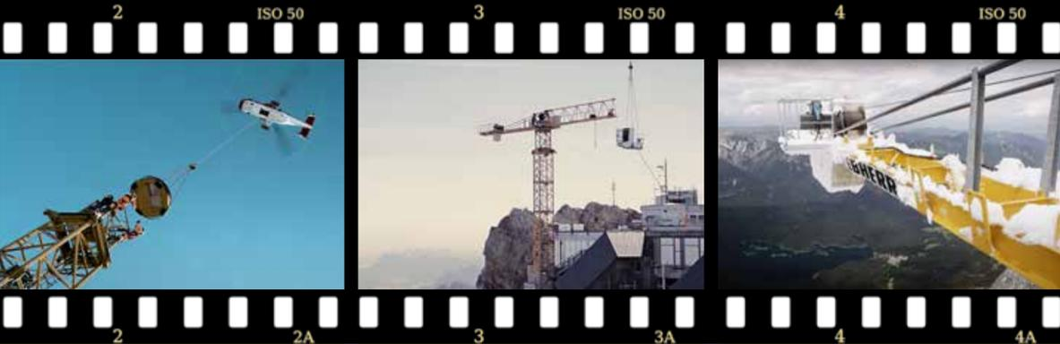
Die Zugspitze ist 2.962 m hoch. Mit spektakulärer Aussicht. Wenig Platz. Und extremen Wind- und Wetterbedingungen. Hier entstand eine neue Seilbahn. Für den Neubau wurde eine Baustelle mit Turmdrehkran am Berg eingerichtet. Der Kran wurde dafür in Einzelteile zerlegt. Und jedes tonnenschwere Kranteil per Helikopter zur Zugspitze hochgeflogen.
